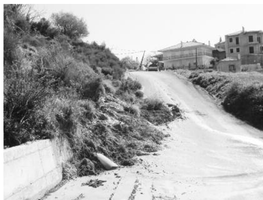
Η κατολίθωση έχει καλύψει τον μισό δρόμο και παραπάνω
