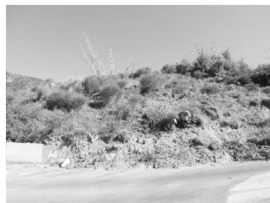
Η κατολίθωση από άλλη γωνία διακρίνονται τα καμένα-κομμένα δένδρα
